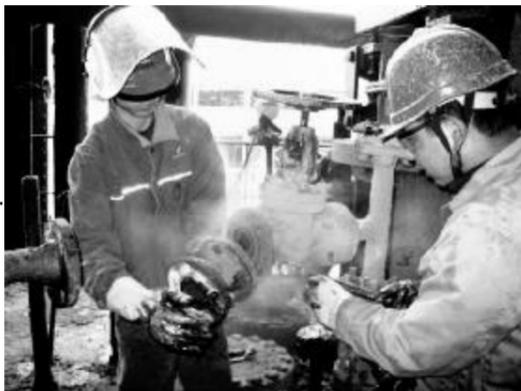
4月11日,氧化铝三分厂对高压溶出一系列停车检修,以确保机组的安全稳定运行。图为检修人员正冒雨检修Ra112出料口阀门。摄影报道 孟青菊 邢建英
