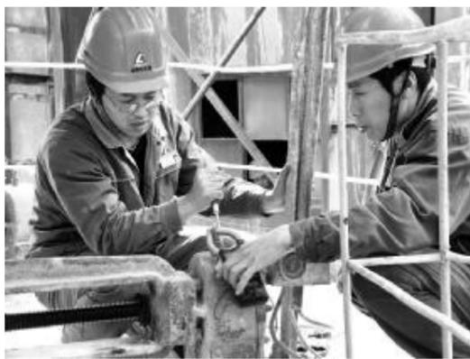
4月10日,氧化铝四分厂六车间对烧结法种分系统和碳分系统进行低产消缺,经过12个小时完成30余项低产消缺任务,为烧结法系统稳定运行创造了良好条件。图为检修人员正在为碳分槽设备消缺。摄影报道 孙佳玲
