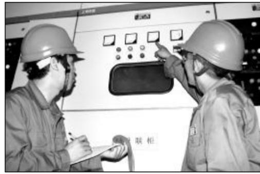
日前,八十万吨氧化铝厂点检站对所有低压配电箱功率补偿柜进行了系统检修,使自动补偿系数达到90%,最高可节省20%的电力消耗。图为电工对母联柜仪表进行检测。摄影报道 任卫红 李军强
