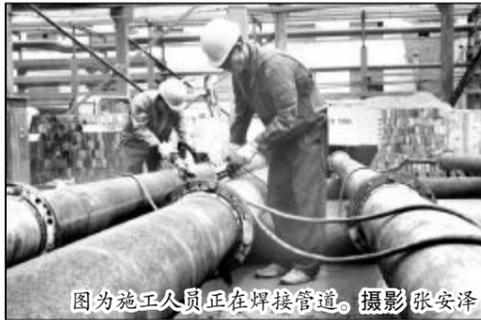
图为施工人员正在焊接管道。摄影张安泽
