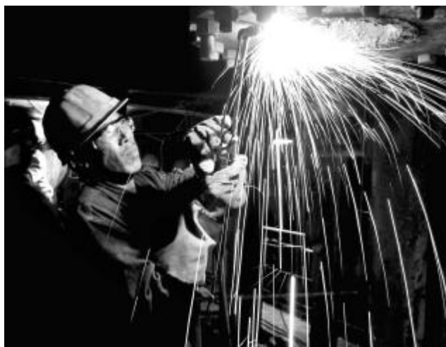
7月3日,氧化铝三分厂对高压溶出一系列进行了计划停车检修。此次检修共涉及检修项目40余个,主要针对两台压煮器进行隔出,投入已火烧清理好的压煮器,同时更换四个高排阀和一个连排阀,并在检修过程中对冷凝水系统、热水槽和大量疏水阀进行清堵。在相关单位配合下,仅用10个小时,顺利完成了所有检修项目,并且一次开车成功。图为检修人员正在焊接单管。摄影报道 邢建英 孟青菊 王强
