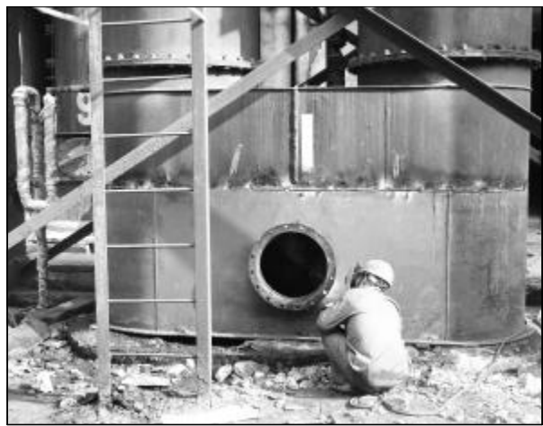
8月11日,煤气分厂造气一车间对发生炉运行系统腐蚀严重的隔离水封进行更换,消除了设备隐患,为氧化铝老系统复产后煤气安全稳定输送提供保障。图为检修人员在对比更换完毕的隔离水封进行焊接。摄影报道 金海波
