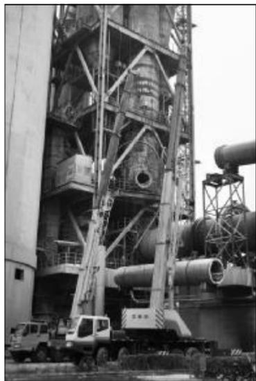
2月15日,山西铝厂水泥厂熟料生产线技改工程开工,晋铝安装公司承担了该项目施工,在制定科学施工方案的同时,组织了钢结构、电气、内衬砌筑等专业施工队伍,力求低成本、高质量、高效率地完成施工任务。图为施工人员对三次热风管第一节进行拆除。摄影报道 刘宏 张安泽
